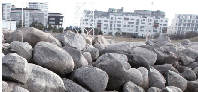
Eksempel på stenkastning
